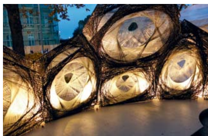
©Leichtbau BW – „Gestricktes Haus“ – Beispiel aus der Faserverbundtechnologie
