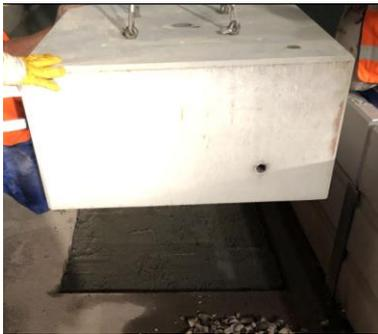
*Abbildung 2.4 – Einbringung der Fundamente.*
