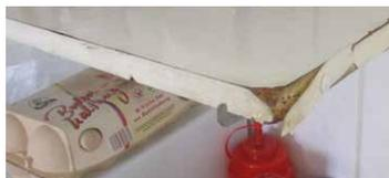
In einem anderen Betrieb war der Umleimer von einer Spanplatte eines Küchenregals abgeplatzt, das dadurch nicht mehr leicht zu reinigen war. Auch lose bzw. verschmutzte oder gar verschimmelte Kühlschrankdichtungen beanstandet die Lebensmittelüberwachung häufig, denn sie werden beim Putzen oft übersehen.
